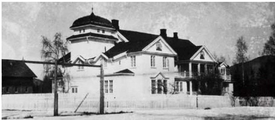
Nes gård. Den gamle hovedbygningen brant i 1959.
